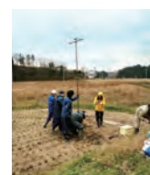
ボーリングによる地質調査の様子
